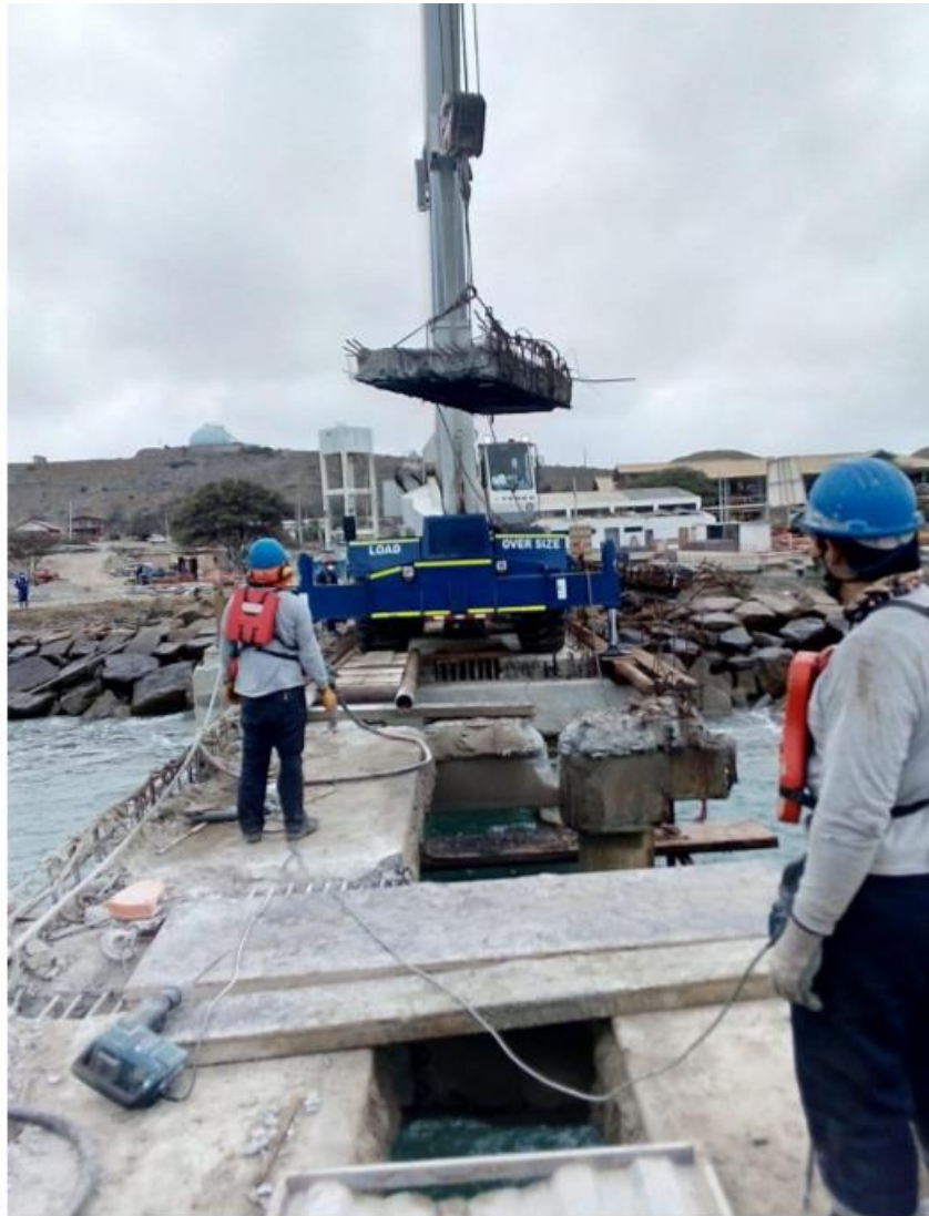
Desmontaje de Losas
