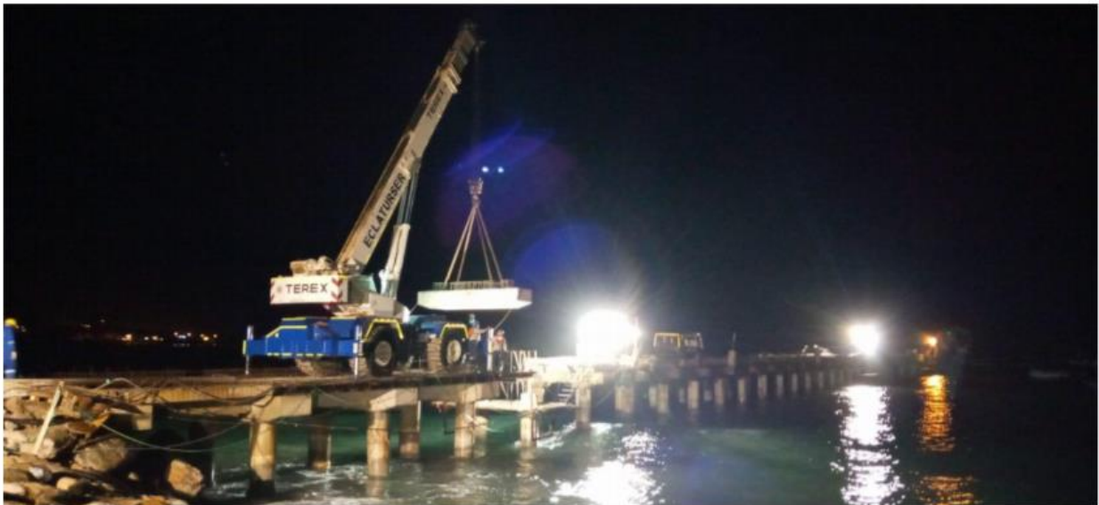
Montaje de Vigas
