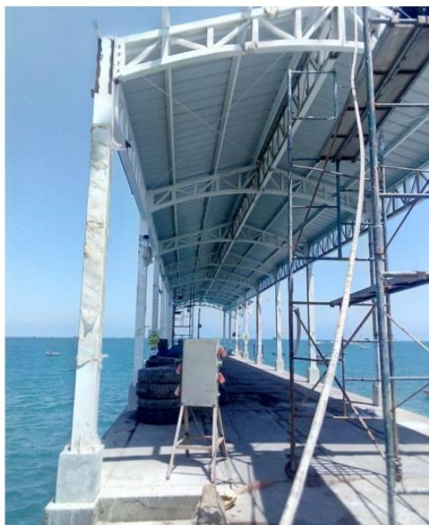
Verificación de suministro e instalación de la cobertura metálica del cabezo N°02
