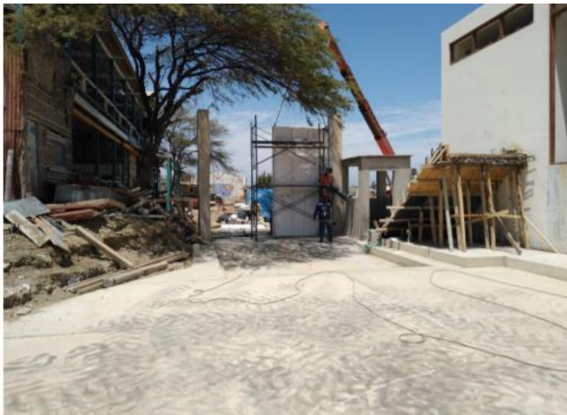
Instalación de Portón de entrada
