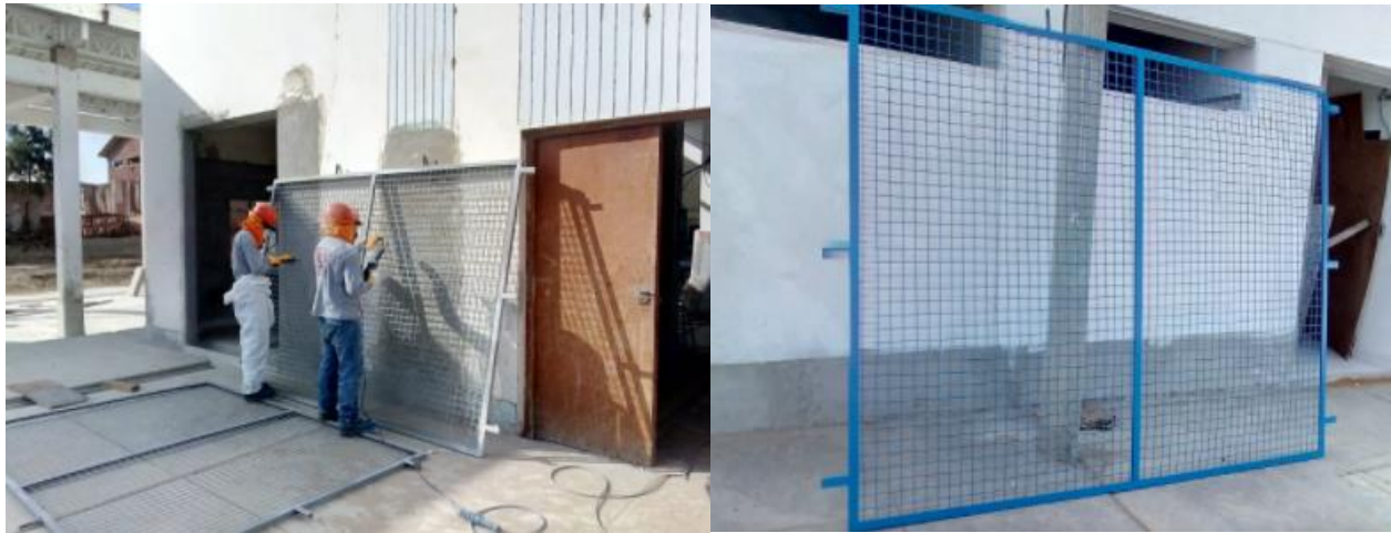
LIMPIEZA Y PINTADO DE MALLA PARA CERCO PERIMÉTRICO
