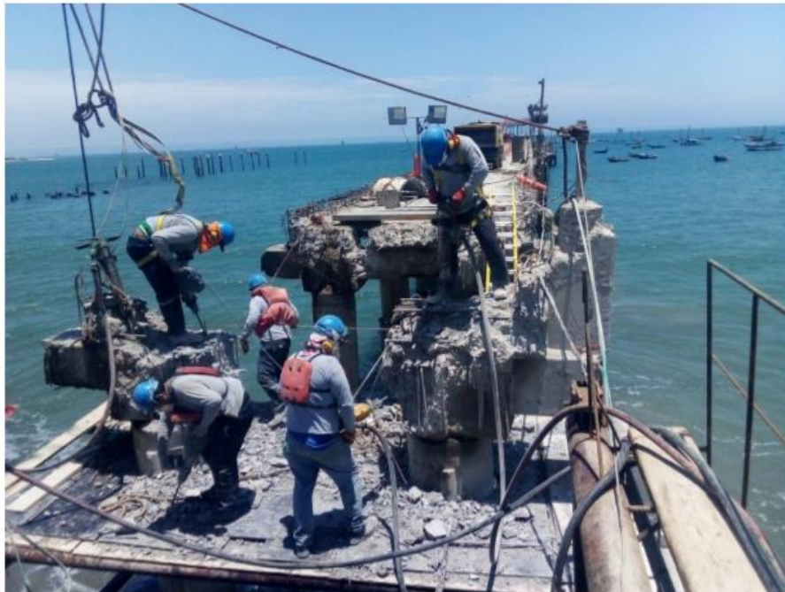
Demolicion de Vigas hasta el Eje N°05
