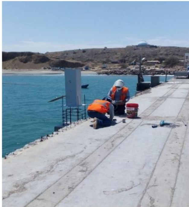
Suministro e Instalacion de Pedestales con Luminarias del Cabezo N°02
