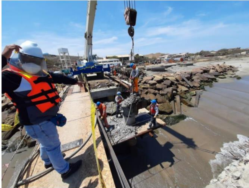
Desmontaje de Vigas
