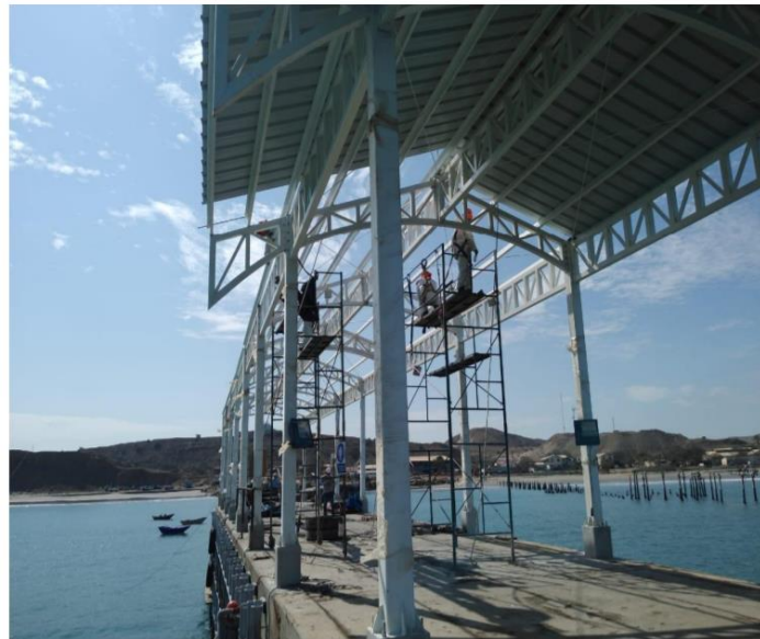
Limpieza de la cobertura metálica del Cabezo N°02
