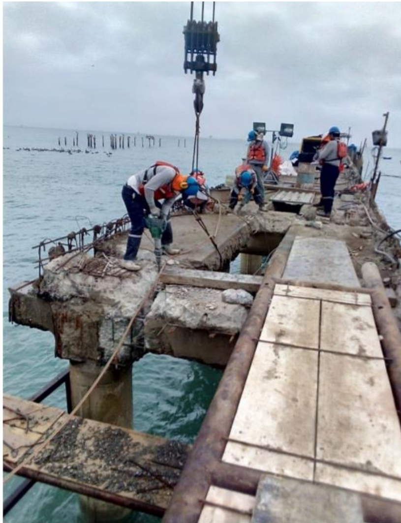
Cortes y Demolición de Losas
