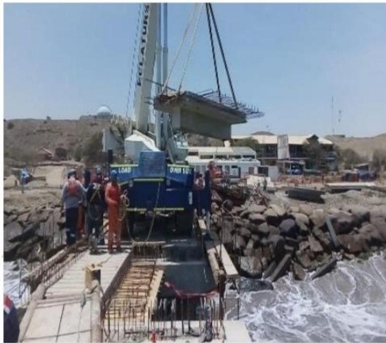
Montaje de Losas
