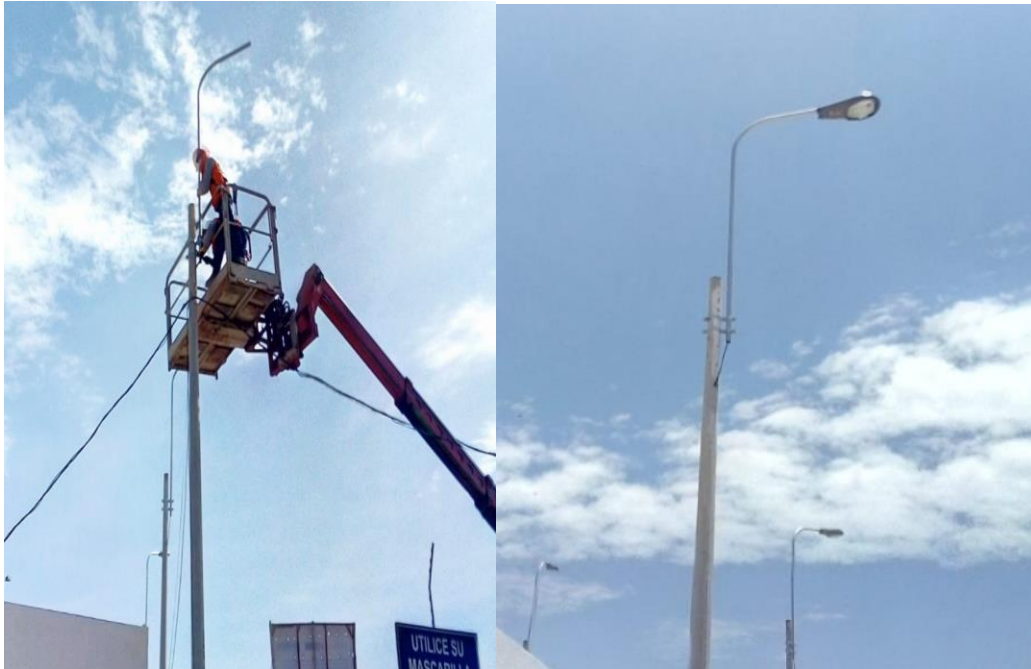
INSTALACION DE POSTES Y PASTORALES DE ILUMINACION
